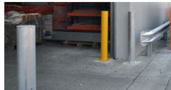
164 mm átmérőjű acélcsőből készült oszlop 250x250 mm-es talplemezzel.
